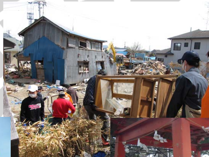
地域復興拠点となる神社のがれき撤去作業
